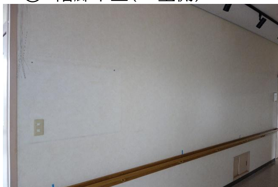
③ 2階廊下壁(A 室側)
