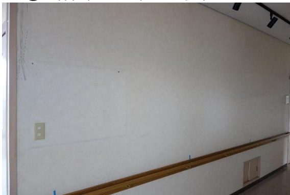
③ 2階廊下壁(A 室側)
