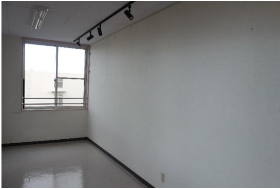
① 2階ホール(B 室側)
