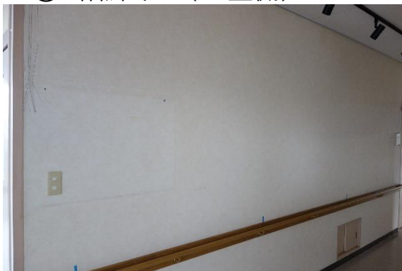
③ 2階廊下壁(A 室側)
